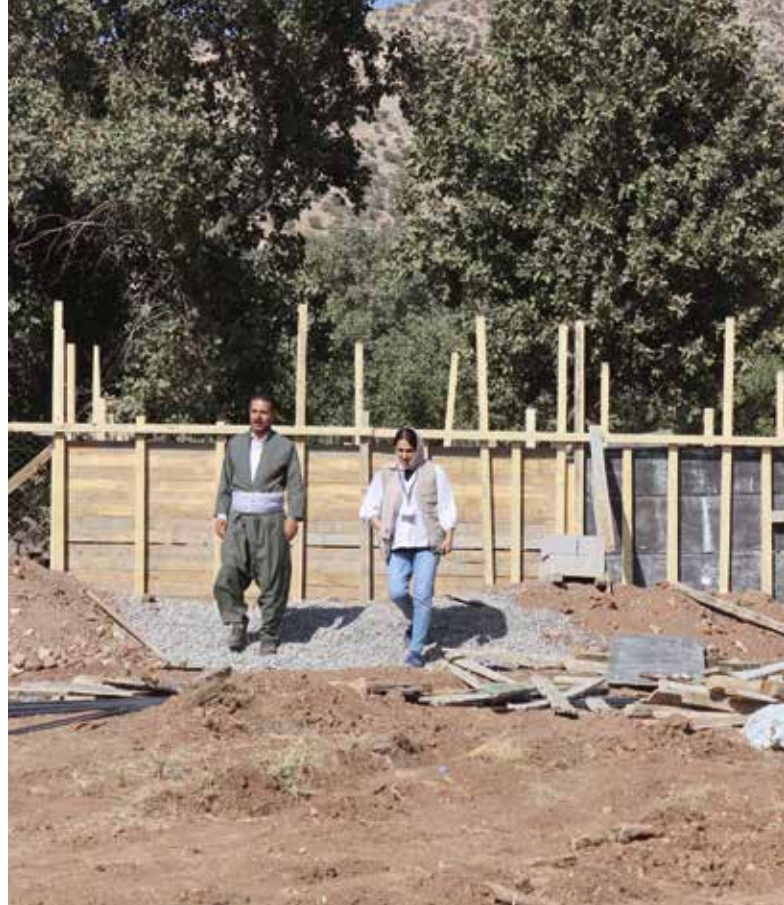
Mit dem Bau von Dämmen und Wasserreservoirs unterstützt CARE die Landwirte dabei, gegen die extreme Trockenheit anzukämpfen.
