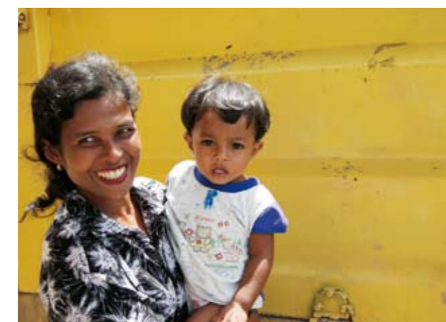
Eine der künftigen Bewohnerinnen freut sich über die Baufortschritte.
